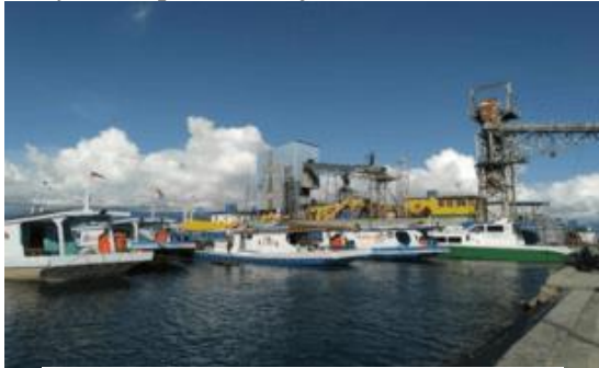
Gambar 1. Kondisi Pelabuhan Donggala
