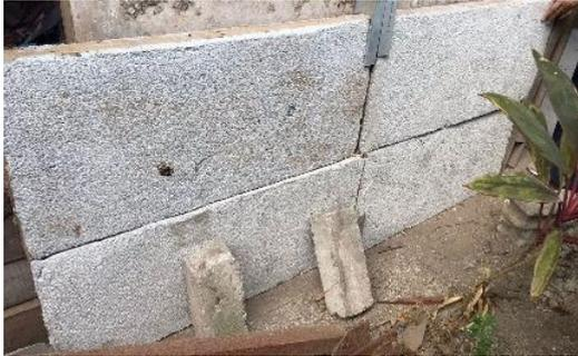
Gambar 8. Hasil pembuatan panel beton pracetak oleh mitra, dimana telah dilakukan tahap plasteran yang selanjutnya setelah terpasang pada dinding bangunan akan dilakukan pengajian agar hasilnya halus dan merata.
