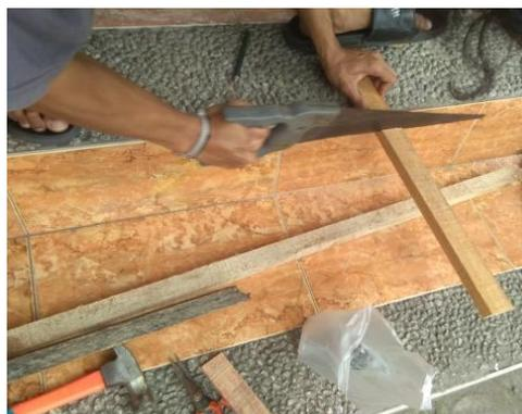
**Gambar 5.** Tim pengabdian melakukan kegiatan pendampingan pembuatan mall/bekisting untuk cetakan panel beton pracetak
