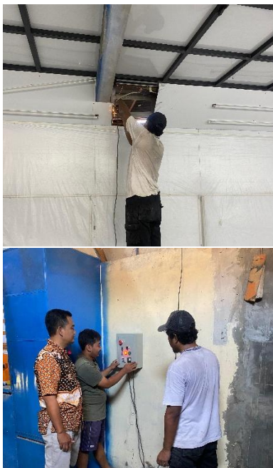
Gambar 5. Pemasangan oven pengecatan Pada spray booth
